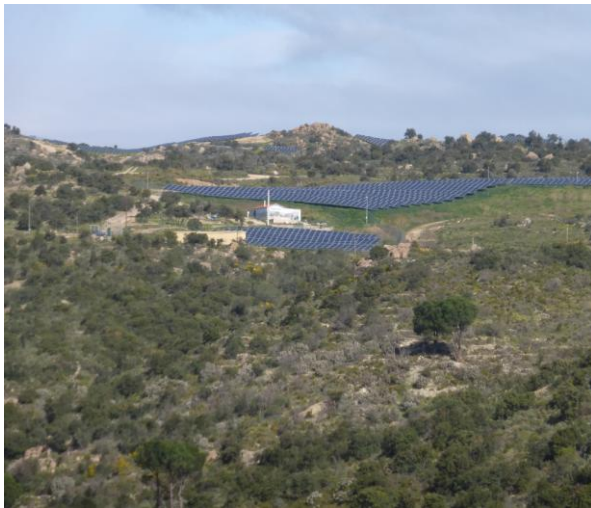
Panneaux photovoltaïques au loin.
